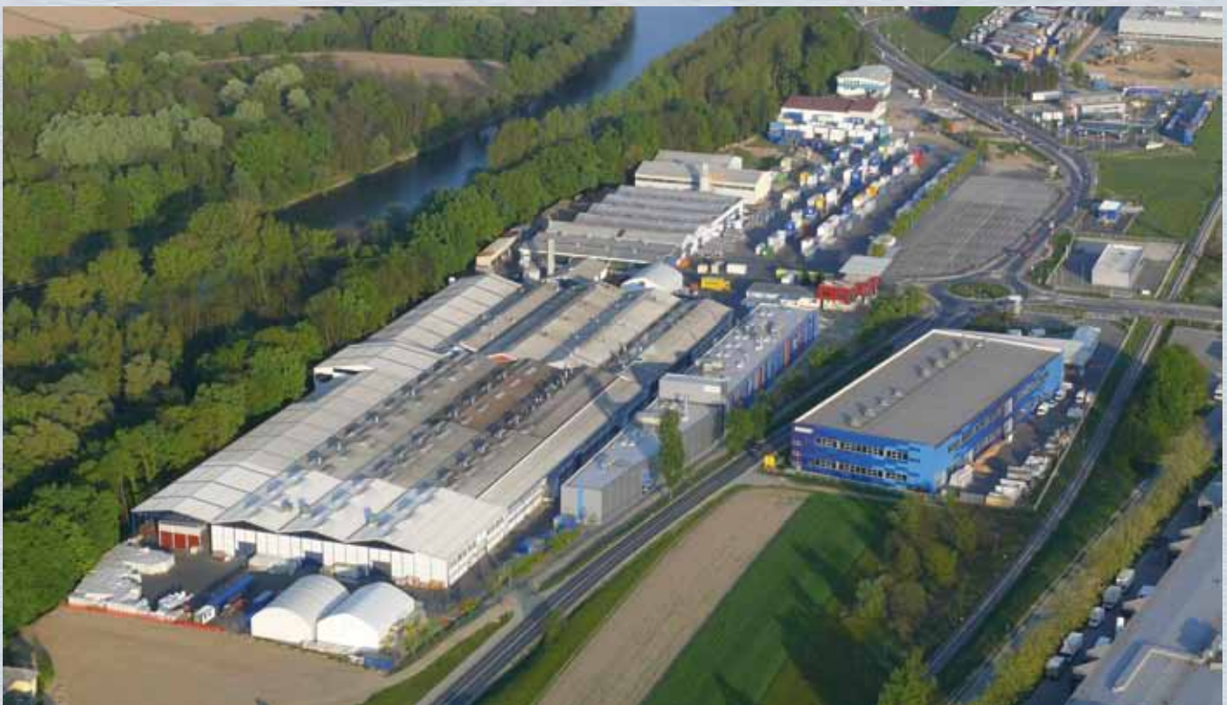
Büro- und Sanitärcontainer-Produktion im Werk SI-Gornja Radgona
